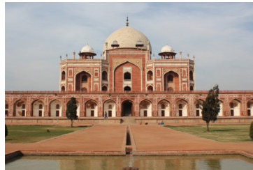
Void over Void
